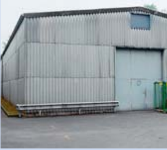
Asbesthaltige Wellplatten
