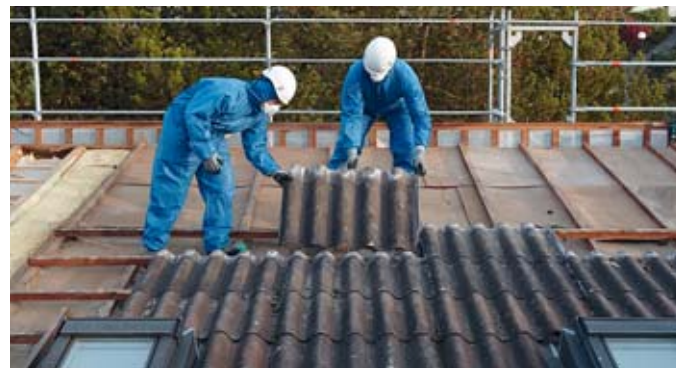
Rückbau von Wellplatten
