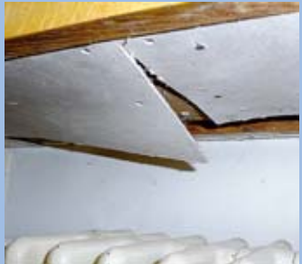
Asbesthaltige Leichtbauplatte
