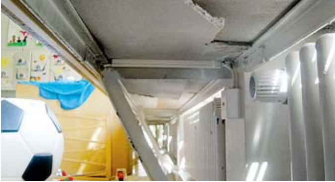
Leichtbauplatte unter Fenstersims ...
