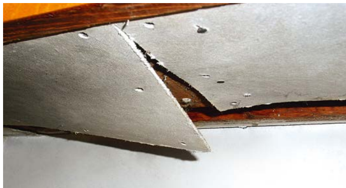
Asbesthaltige Leichtbauplatten
