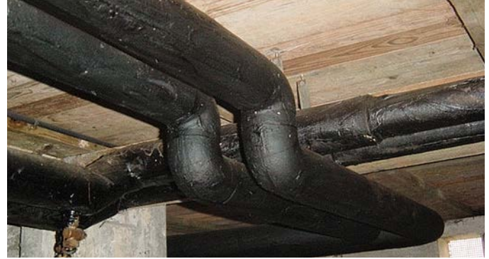
Bitumenbeschichtung
