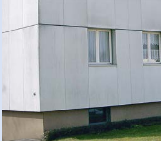
Asbesthaltige Fassadenplatten
