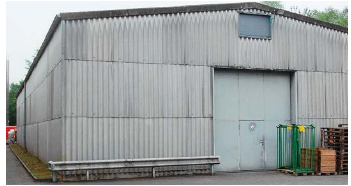
Asbesthaltige Wellplatten
