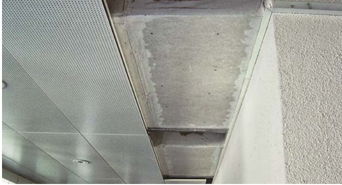
Asbesthaltige Deckenplatten
