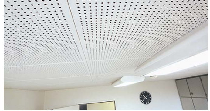
Deckenplatten bei abgehängten Decken
