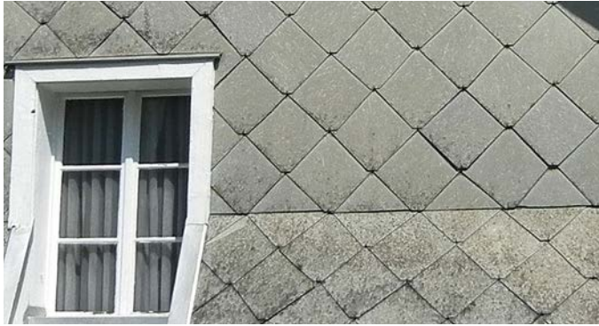
Asbesthaltige Fassadenplatten
