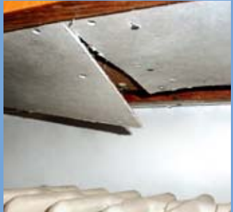
Asbesthaltige Leichtbauplatten
