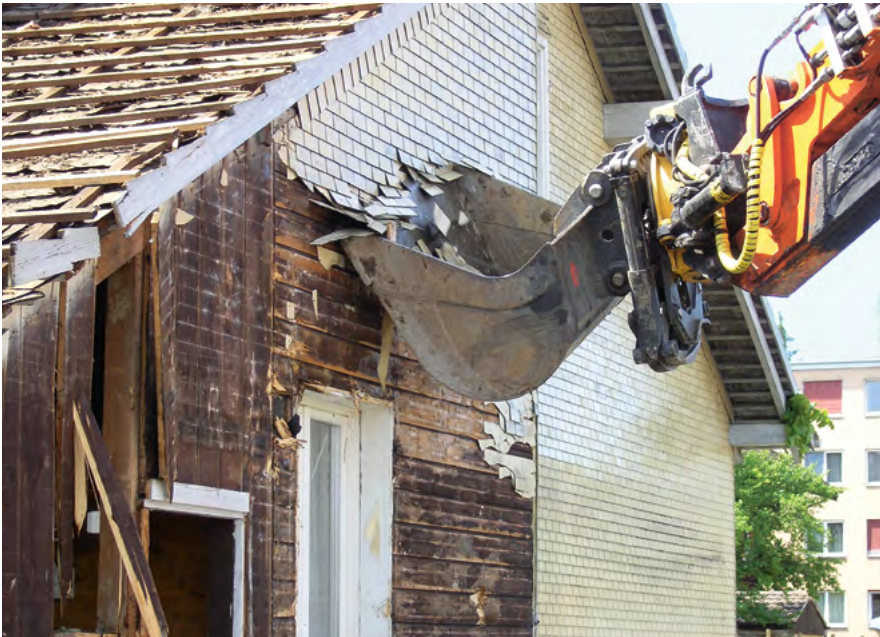
3 Asbesthaltige Faserzementschindeln
