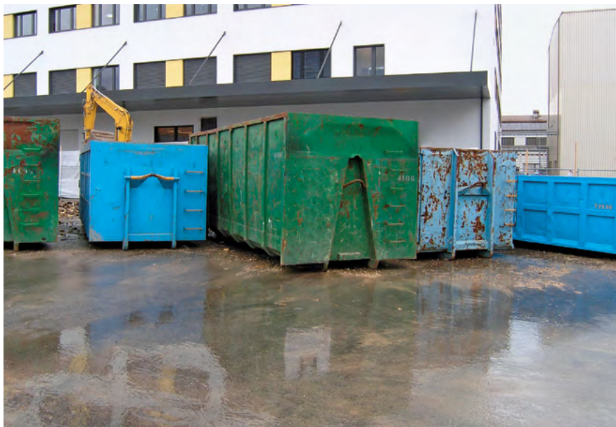
2 Abfallmulden für Asbest
