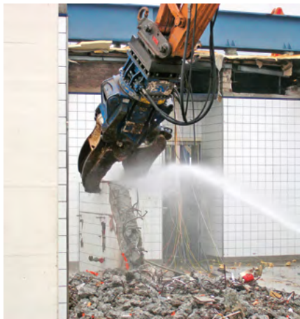
7 Keramikplatten mit asbesthaltigem Plattenkleber
