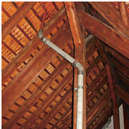
6 Asbesthaltige Faserzementleitungen
